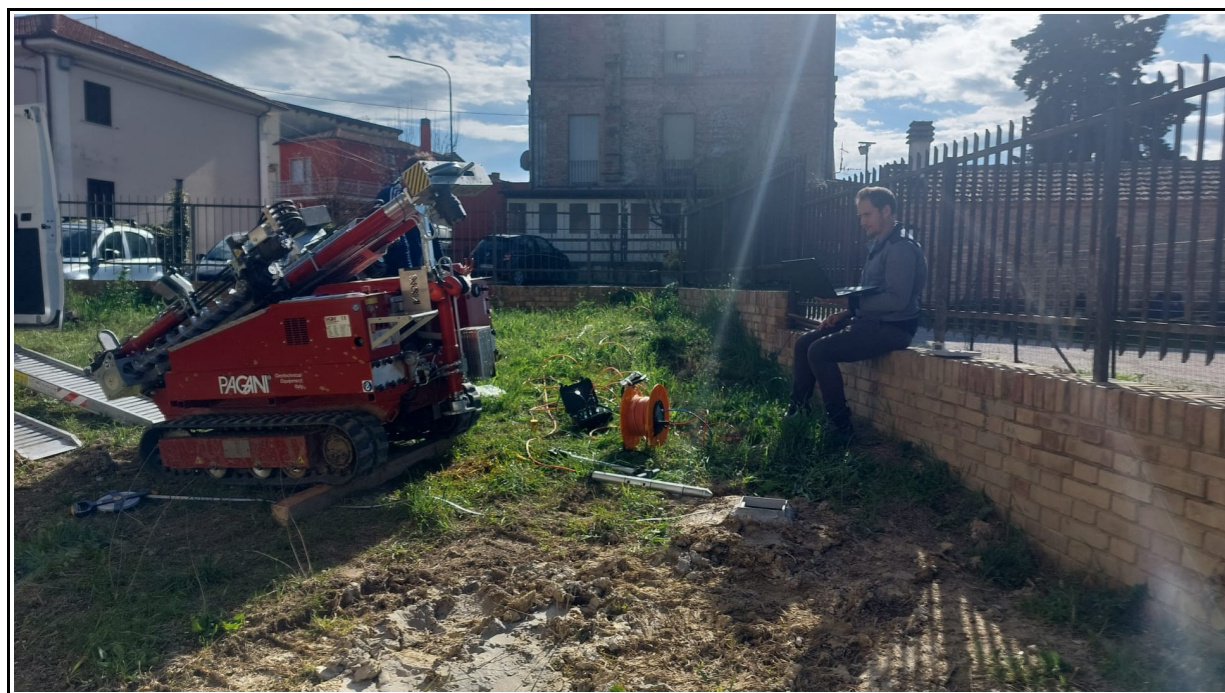
Sondaggio S1 – Esecuzione prova sismica in foro DOWN-HOLE
